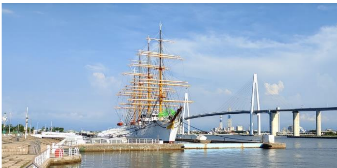
帆船海王丸と新湊大橋
